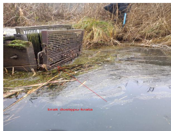
Fot. 6. Wlot budowli wpustowej do stawu (od strony użytku ekologicznego)
