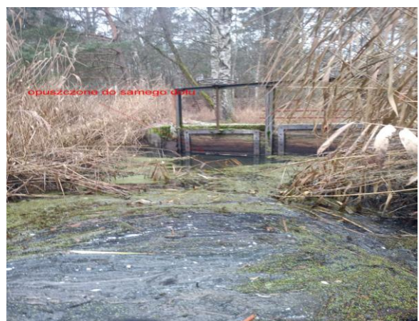
Fot. 5. Wlot do przepustu nieczynne zasuwę
