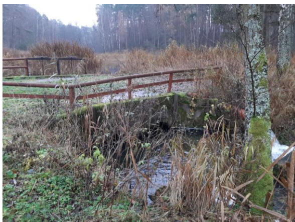
Fot. 3. Przyczółek wylotowy przepustu
